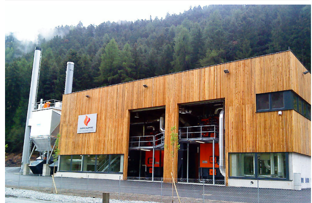
Abb. 4.10: Heizzentrale der Ortswärme Zams
